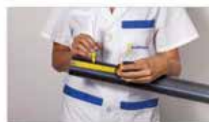
Marcare l'area da raschiare.
