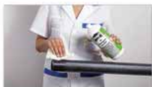
Nettoyez les surfaces avec un détergent approprié.
