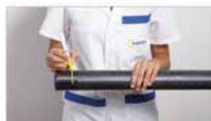
Marquer la profondeur d'insertion.
