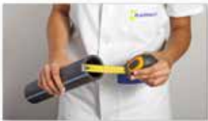
Controlar las dimensiones de los elementos a soldar.
