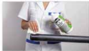
Limpiar las superficies con el detergente idóneo.
