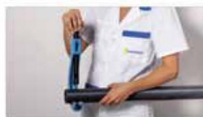
Coupez le tuyau avec le coupe-tube.
