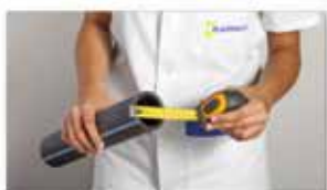
Controllare le dimensioni degli elementi da saldare.
