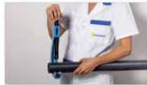
Cortar el tubo con los tronzadores.
